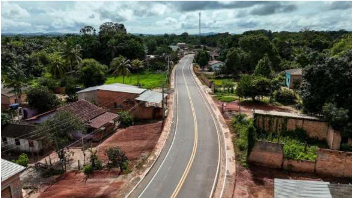
Imagem n°03– Construção e Pavimentação da Vicinal do Cuamba
