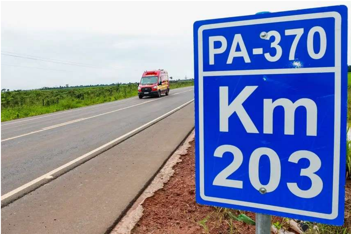
Imagem n°07 – Construção e Pavimentação da PA-370
