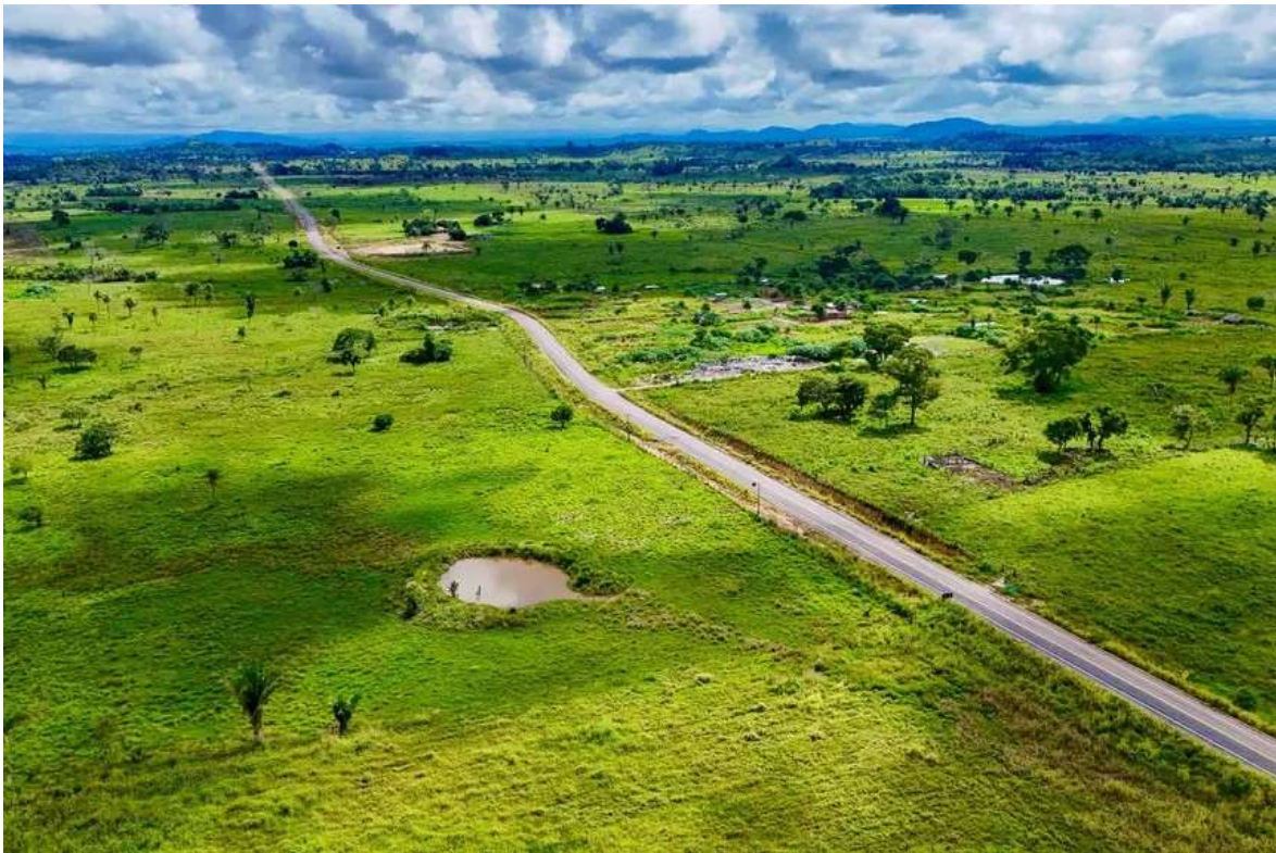
Imagem n°12 – Construção e Pavimentação da PA-279 (Transcanadá)
