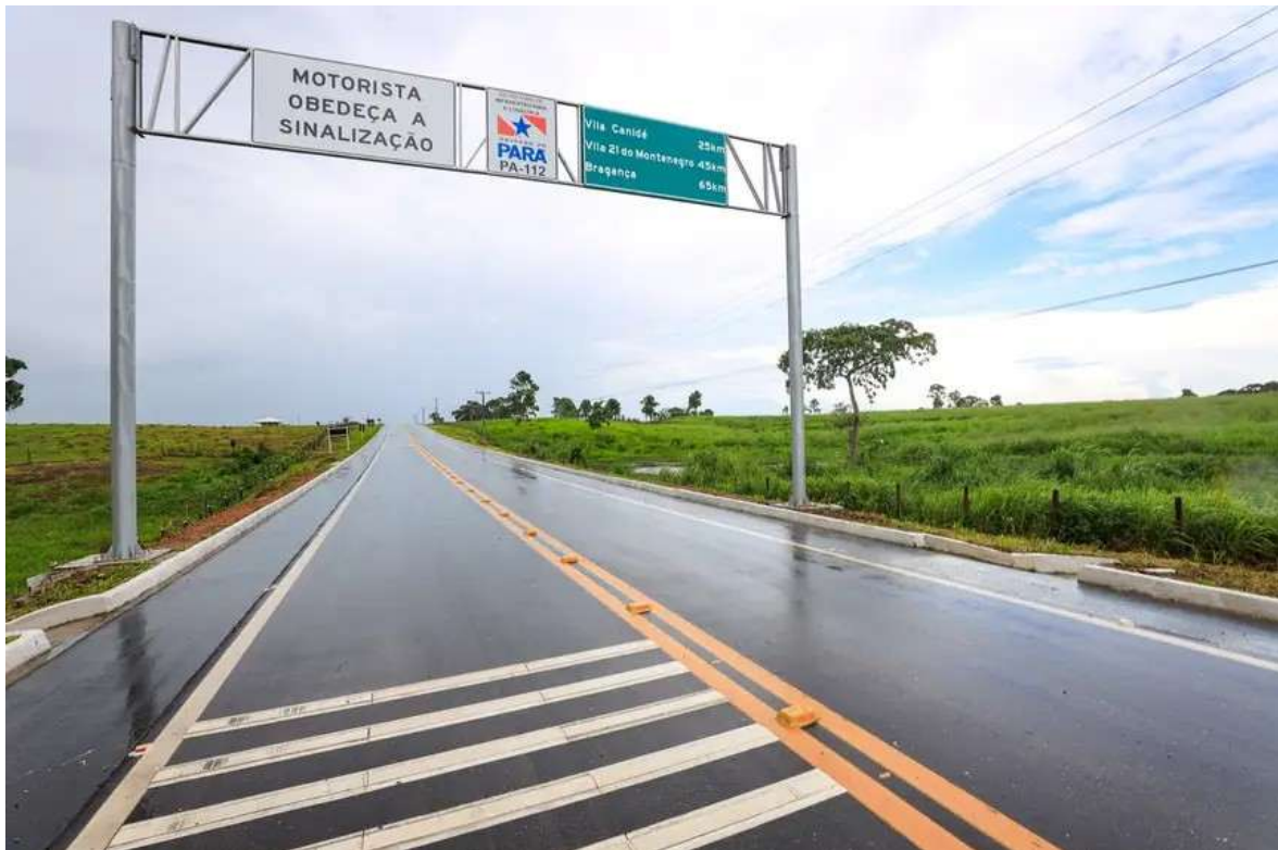
Imagem n°x – Construção e Pavimentação da PA-112
