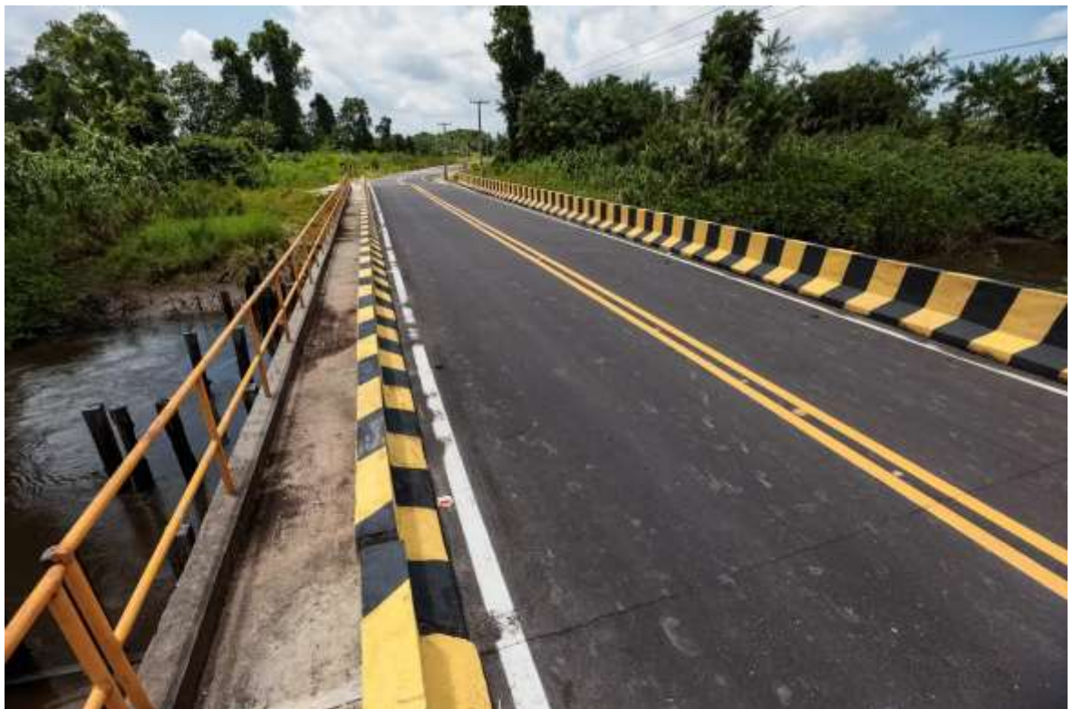
Imagem n°x – Construção e Pavimentação da PA-279 (Transcanadá)
