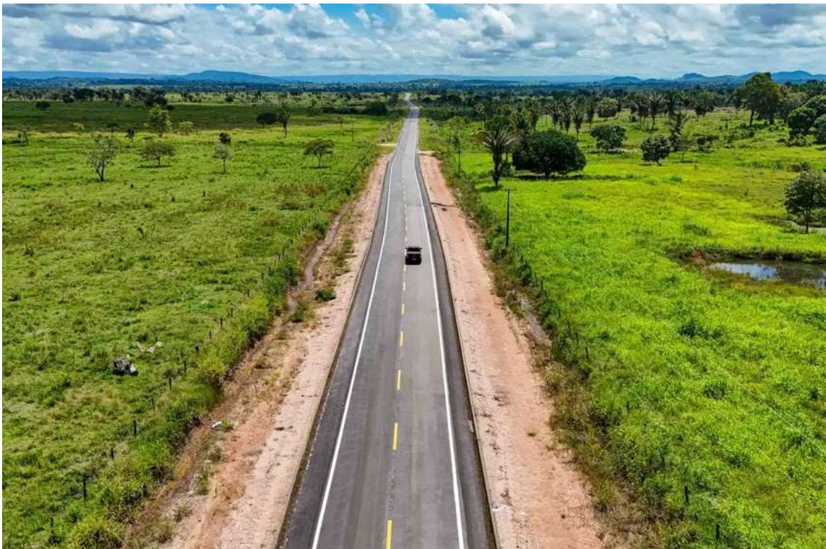
Imagem n°11 – Construção e Pavimentação da PA-279 (Transcanadá)
