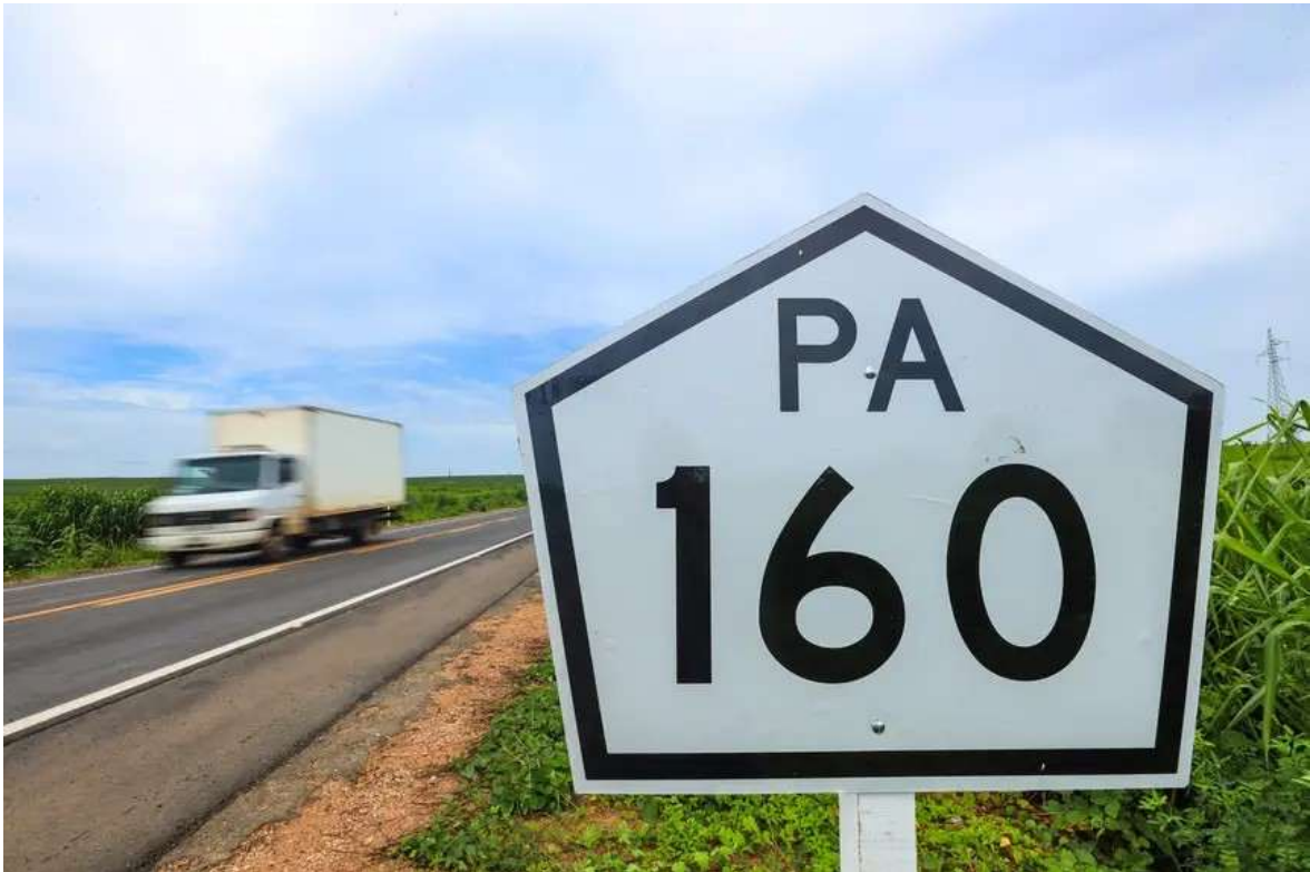
Imagem nº05 – Construção e Pavimentação da PA-160
