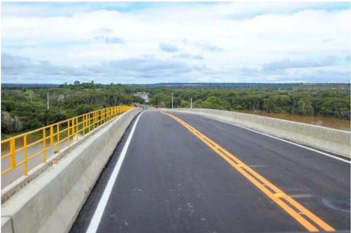
Imagem n°x – Construção de 1(uma) ponte sobre o Rio Alto Capim
