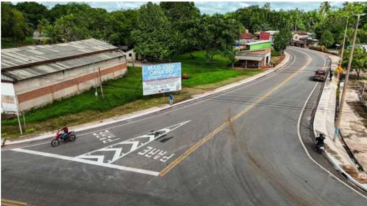
Imagem nº02 – Construção e Pavimentação da Vicinal do Cuamba
