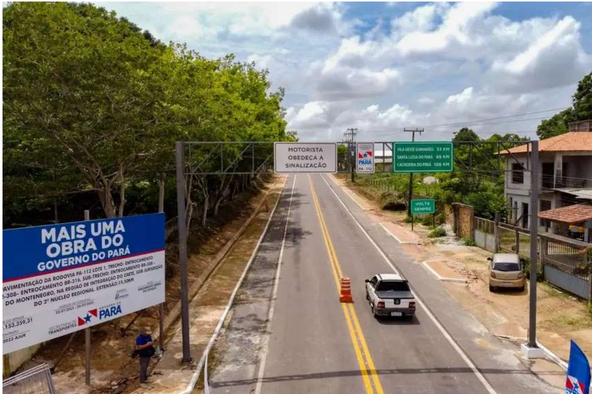
Imagem n°x – Construção e Pavimentação da PA-112
