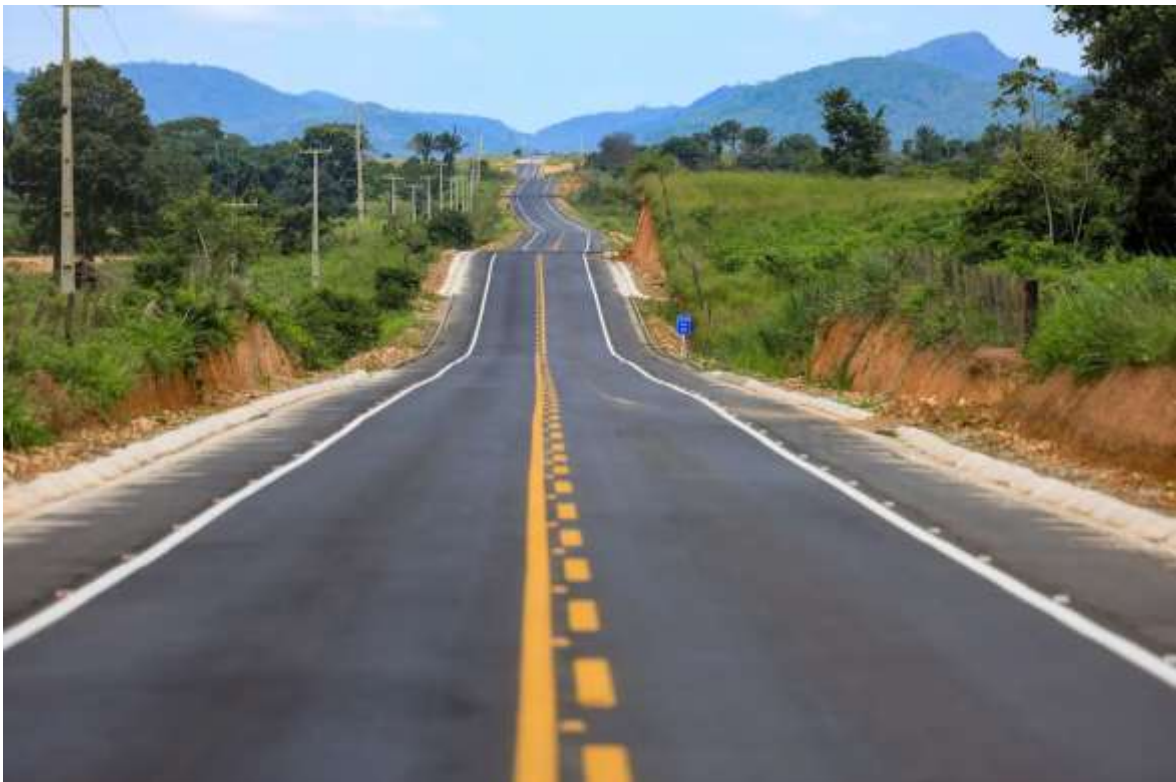
Imagem nº06 – Construção e Pavimentação da PA-160
