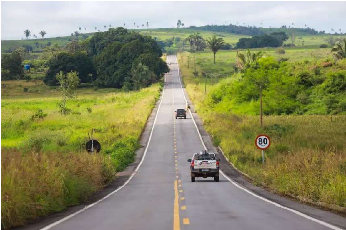
Imagem n°10 – Construção e Pavimentação da PA-279 (Transcanadá)
