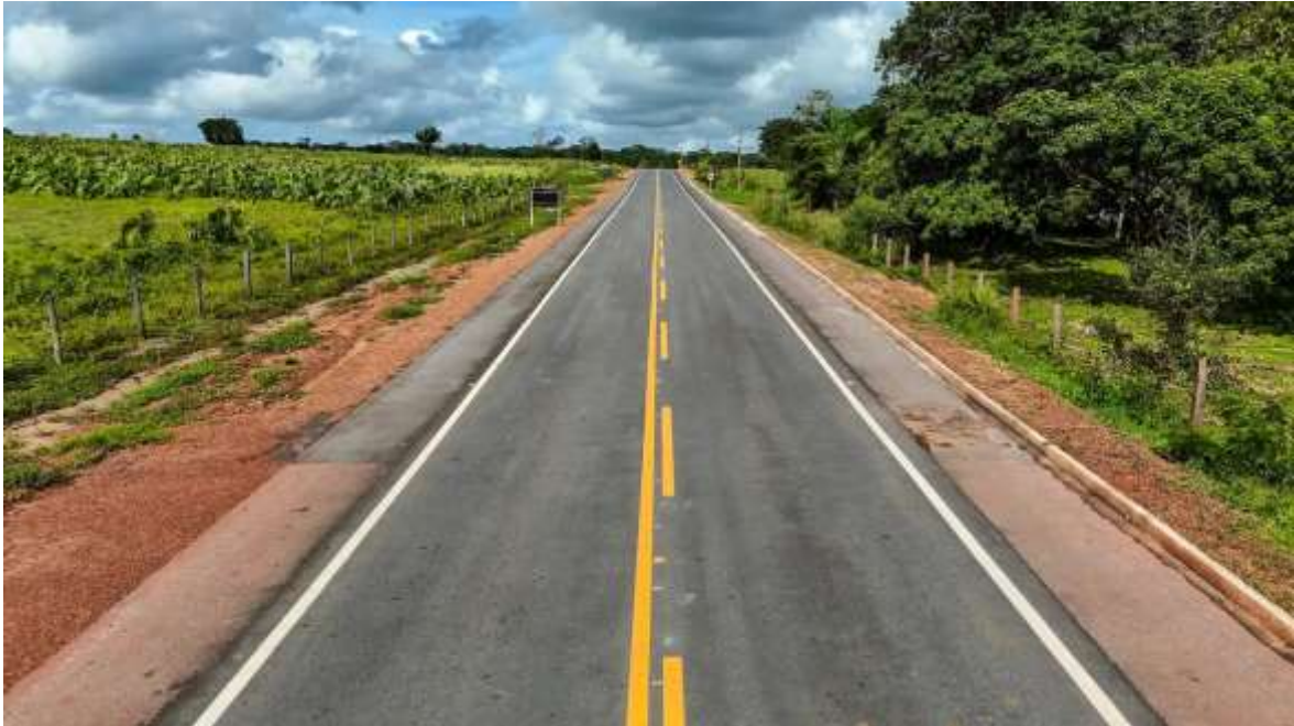
Imagem nº01 – Construção e Pavimentação da Vicinal do Cuamba
