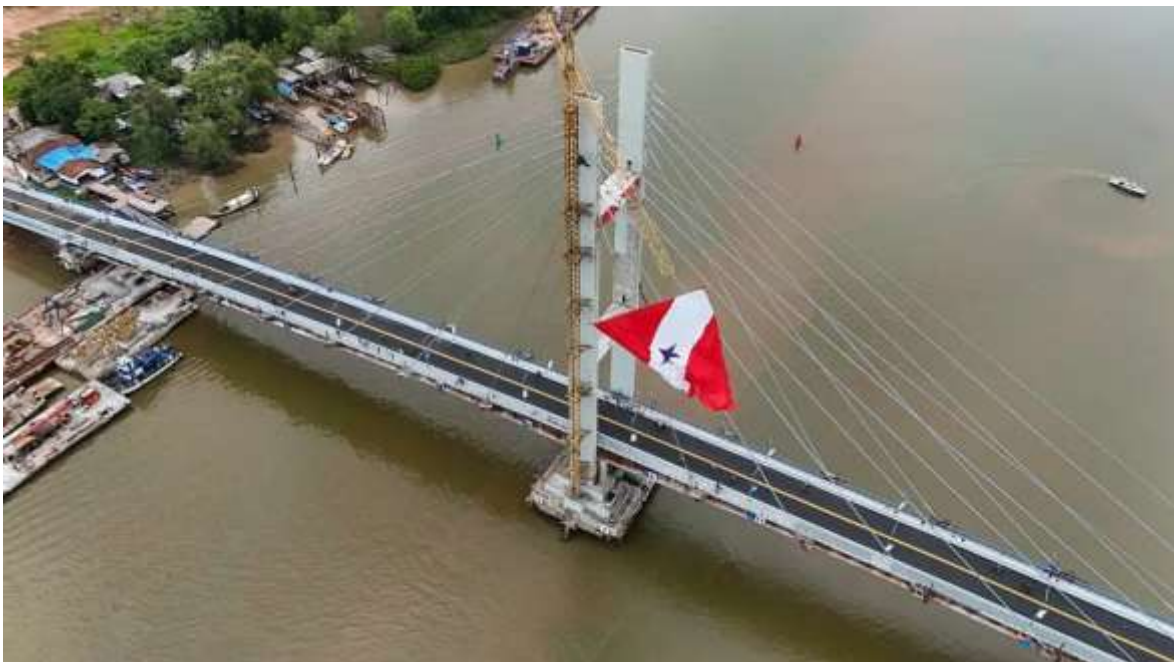
Imagem n°13 – Construção de 1(uma) ponte sobre o furo Maguari.
