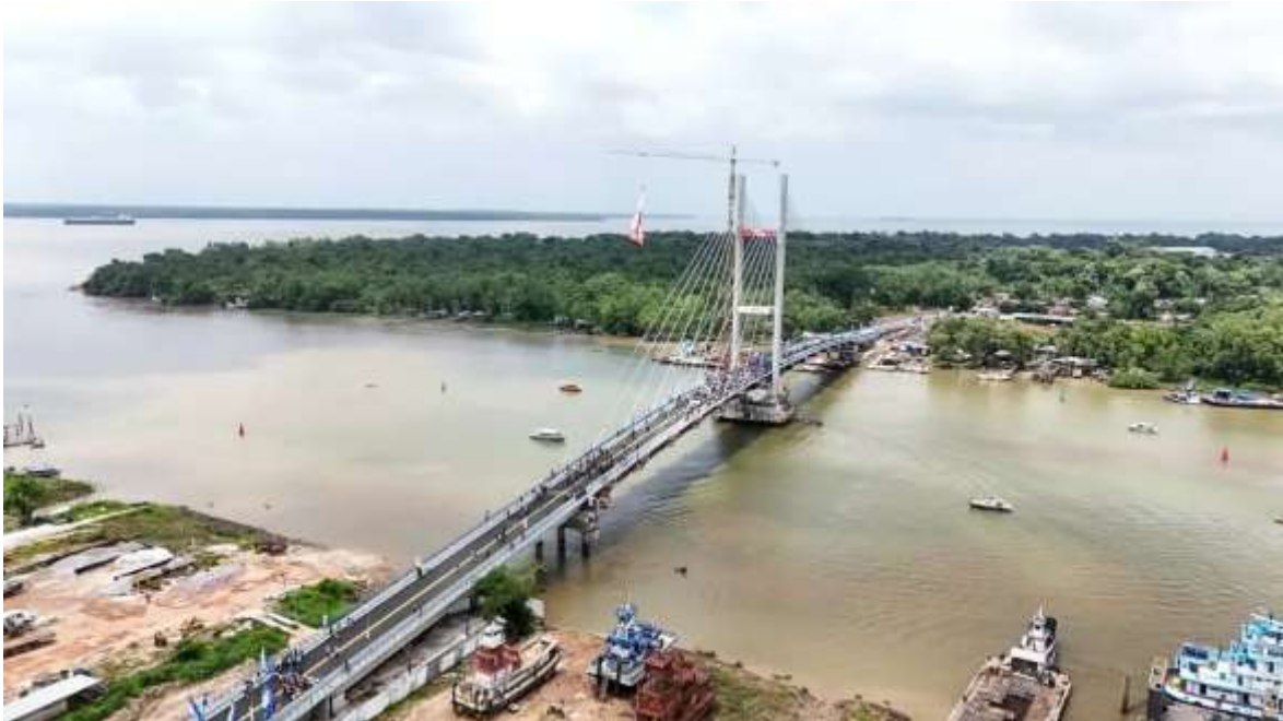
Imagem n°14 – Construção de 1(uma) ponte sobre o furo Maguari
