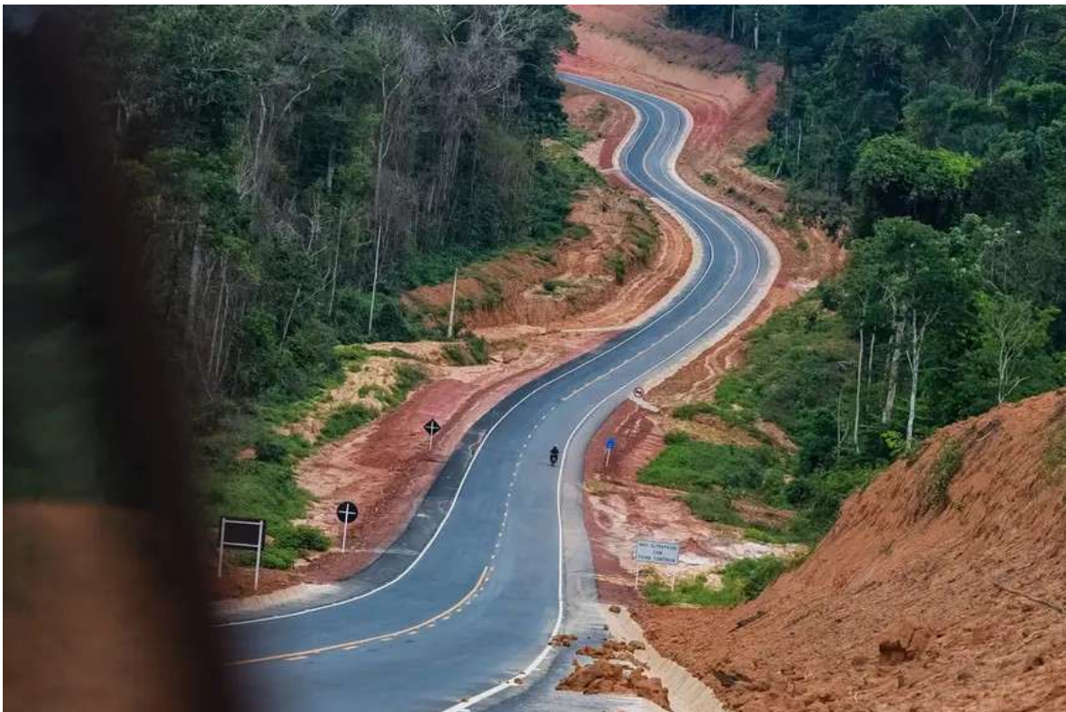
Imagem n°08 – Construção e Pavimentação da PA-370
