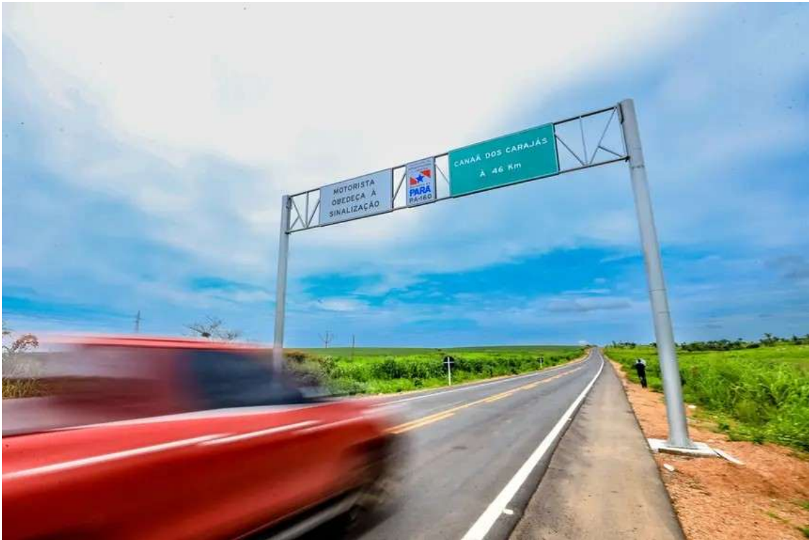
Imagem nº04 – Construção e Pavimentação da PA-160
