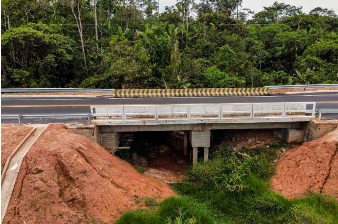
Imagem n°x – Construção e Pavimentação da PA-112
