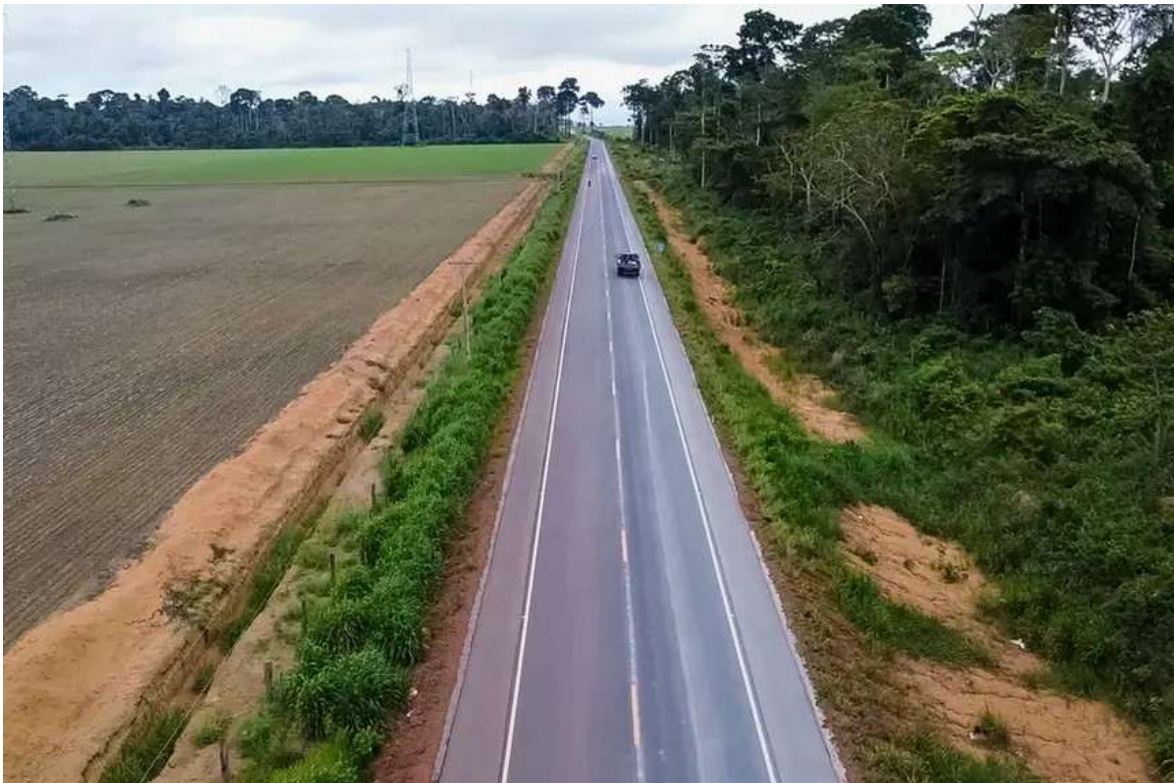
Imagem n°09 – Construção e Pavimentação da PA-370
