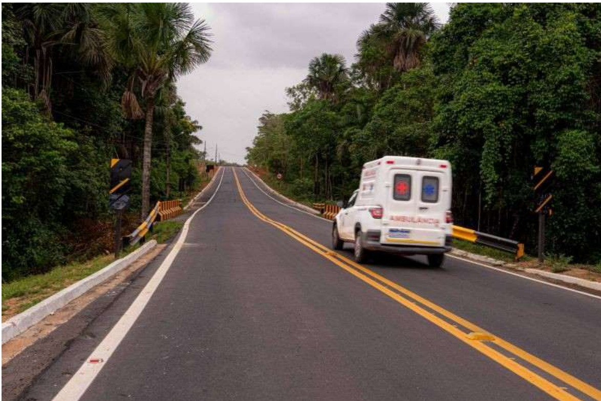
Imagem n°x – Construção e Pavimentação da PA-112
