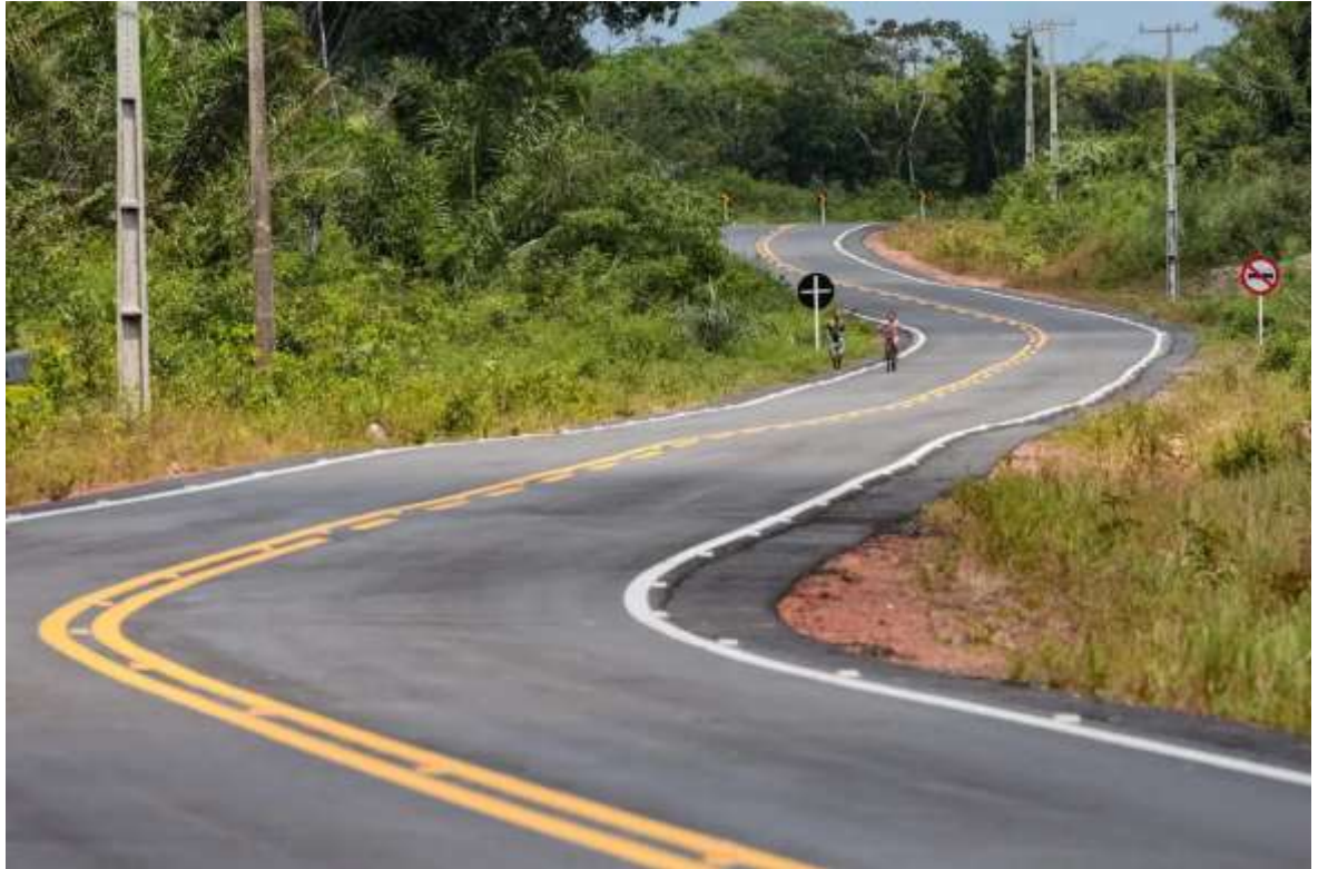
Imagem n°x – Construção e Pavimentação da PA-279 (Transcanadá)
